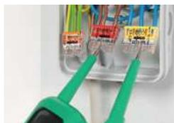
Die Prüfung erfolgt in der Prüföffnung auf der den Leitereinführungen entgegengesetzten Klemmenseite.
