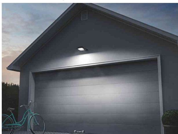
Exemple d'utilisation dans un garage
