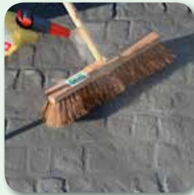
Erhärten des Mörtels auf der Oberfläche vermeiden
