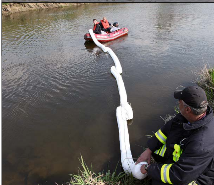
DENSORB Ölsperren (hier: 6-m-Segmente) zum Eindämmen und Aufnehmen von Ölverschmutzungen auf Wasseroberflächen
