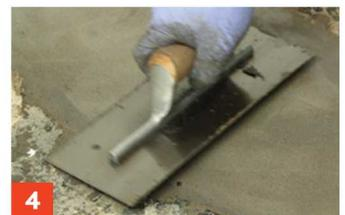
**4** Für eines schönes Finish die Kelle mit Terpentinersatz benetzen und über die Reparatur streichen
