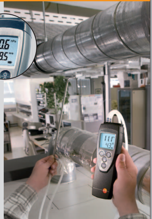
Messung von Prozessluft
