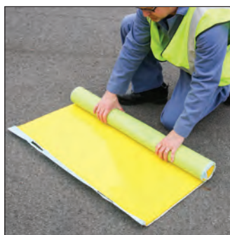
Die gereinigte Abdeckung mit der Polyurethaneite nach oben auf das Silikongewebe aufrollen.
