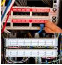
Dank spezieller Tasten können elektrische Anschlüsse, Verteilerkästen, Steckfelder oder Klemmblöcke für den Telekommunikationsbereich oder das Elektrohandwerk beschriftet werden. Außerdem können klar lesbare Fähnchen- oder Umlaufetiketten schnell und einfach ausgedruckt werden.
