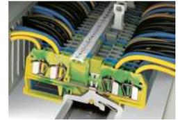
Stahltragschienen sind gemäß EN 60947-7-2 (VDE 0611, Teil 3) nicht für PEN-Anwendungen geeignet (PEN = Schutz- und Neutralleiter).
