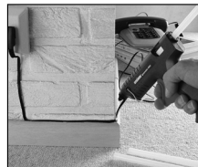
Förläggning av telefonkabel.
