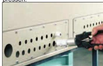
**FERTIG** Die Montagezange nach der Pressung aus der PLIO-SPEED herausziehen.
