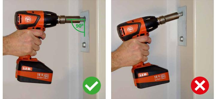
Die Schrauben werden rechtwinklich zur Bauteiloberfläche montiert
