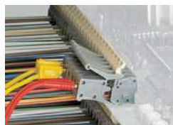
Prüfen mit Prüfsteckermodulen
