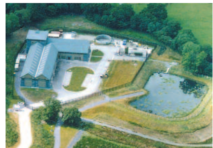
Beispiel für eine schwer erreichbare Pumpstation.
