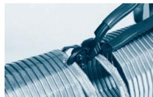
Schritt 3: Überstehendes Profil mit Blechschere oder Zange abschneiden.
