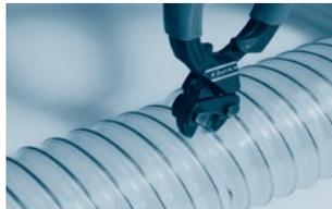
Schritt 2: Stützwendel mittels Zange durchtrennen.
