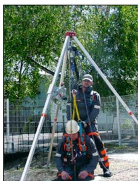
Anwendungsbeispiel für den Schachteinstieg mit einem Dreibock und dem Auf- und Abseilgerät. Bei Positionierung mit dem Gerät / Arbeiten am Seil ist eine zweite Sicherung (Redundanz) vorgeschrieben. Dafür empfehlen wir ein mitlaufendes Auffanggerät oder ein Höhensicherungsgerät mit Rettungshub.
