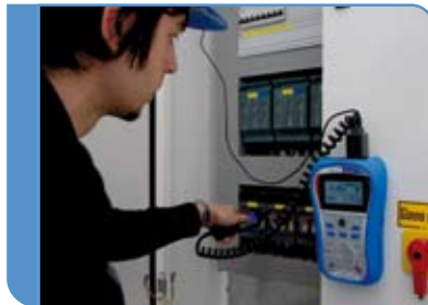
Prüfen der Impedanz an der Schaltschränken.
