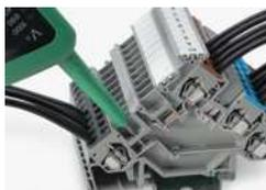
Prüfen mit Spannungsprüfer direkt an der Stromschiene
