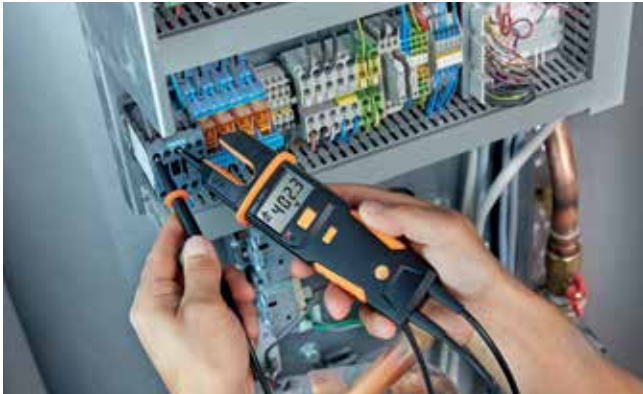
Spannungsprüfung an einer Wärmepumpe mit testo 755 .
