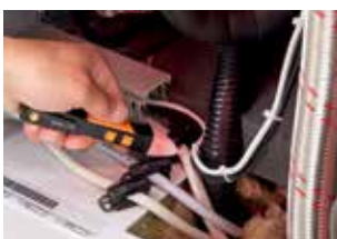
Erstprüfung der Spannungsversorgung an einem Verdichter.
