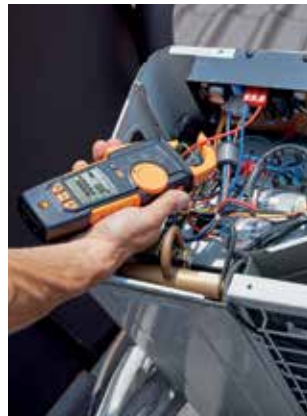
Einfädeln der Stromzange an einer Kälte-Außeneinheit.
