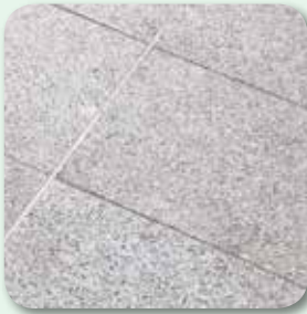
Klebebänder direkt im Anschluss entfernen
