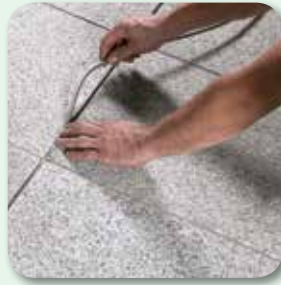
Fugentiefe durch PE-Rundschnur fixieren
