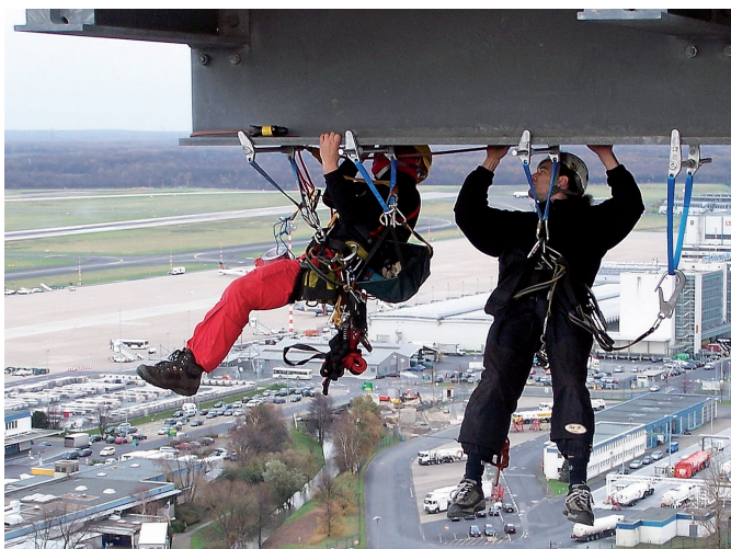
Verbindungsmittel mit integriertem Falldämpfer (EN 354/EN 355).
