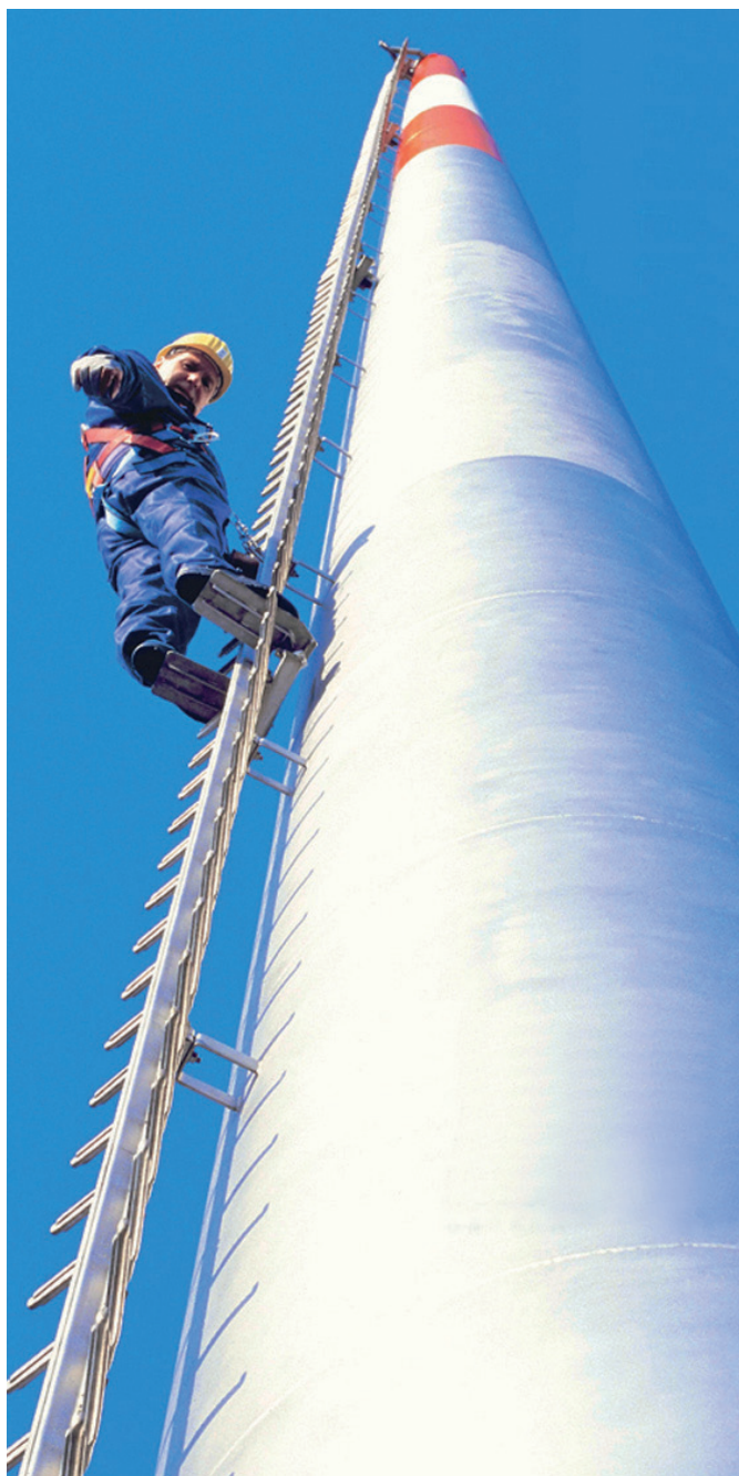
Steigschutzeinrichtung mit fester Führung (EN 353-1)
