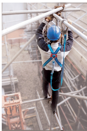
Verbindungsmittel mit integriertem Falldämpfer (EN 354/EN 355).
