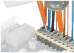
Prüfen mit Prüfspitzen
