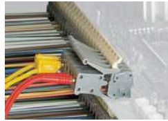
Prüfen mit Prüfsteckern
