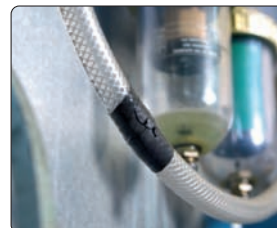
Abdichten eines Druckluftschlauches
