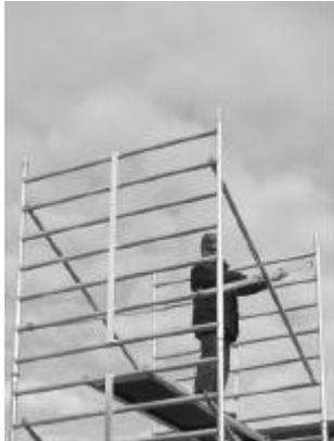
Zwei Diagonalstreben in die zweiten Querrohre der Aufsteckrahmen einsetzen.
