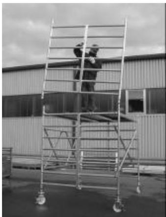
Aufsteckrahmen wie im Bild dargestellt auf den Grundrahmen aufstecken. Die Aufsteckrahmen müssen mit den Federsteckern am Grundrahmen gesichert werden.
