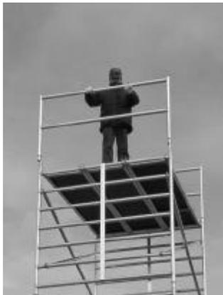
Der obere Abschluß bilden die Geländerrahmen. Die Stirngeländer müssen auf den obersten Austeckrahmen aufgesteckt und mit den Federsteckern gesichert werden.
