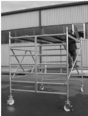
Setzen Sie die weiteren Arbeitsplattformen in die obersten Querrohre ein. Zwischenbühnen müssen vollflächig ausgelegt werden. Der Aufstieg zur Arbeitsplattform darf nur von innen erfolgen.
