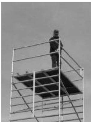
Längsseitige Geländerrahmen von innen nach außen wie im Bild dargestellt einsetzen.
