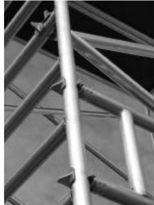
Hilfsplattform in die obersten Querrohre einsetzen. Schnellverschluß auf Einrasten prüfen.
