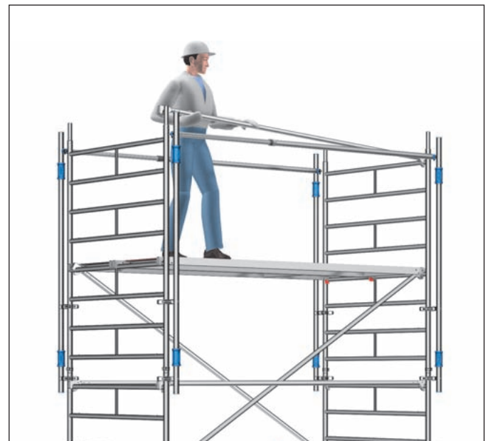
Bild 6: Sichere Montage der Rückenlehnen mit MSG
