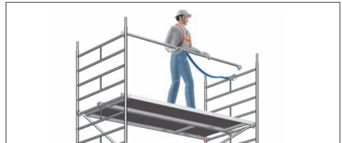
Bild 3: Sichere Montage der Rückenlehnen mit PSA
