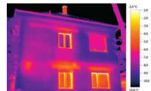
Wärmebild mit testo ScaleAssist
