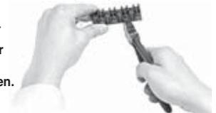
2. Die Klemmleiste an beliebiger Stelle anschneiden und mit den beiliegenden Kreuzschlitz-Senkkopfschrauben an der Montagestelle befestigen.
