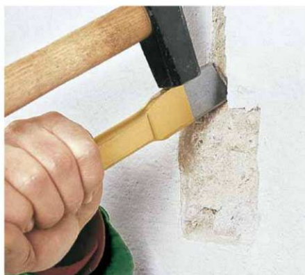
Elektrikerschlitzmeißel Electrician's slotting chisels
