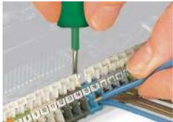
Leiter anschließen/lösen – Serie 256.
