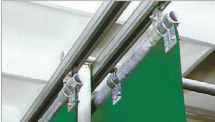
Schiebetüren beschleunigen den Werksverkehr und ermöglichen freie Durchfahrt.
