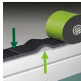
Bild 2: Das Band an einem Bandstoß mit einer Längereserve verlegen.
