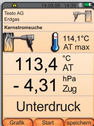
Das Ergebnis der Messung: ein Unterdruck liegt vor (-4,31 hPa)
