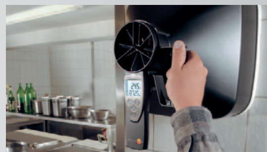
Kontrolle der Abluft an einem Aufputzlüfter
