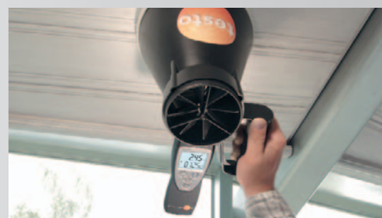
Kontrolle der Zuluft an einem Tellerventil
