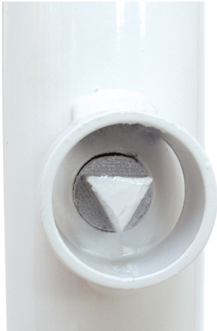
Detailansicht: Feuerwehr-Dreikantverschluß
