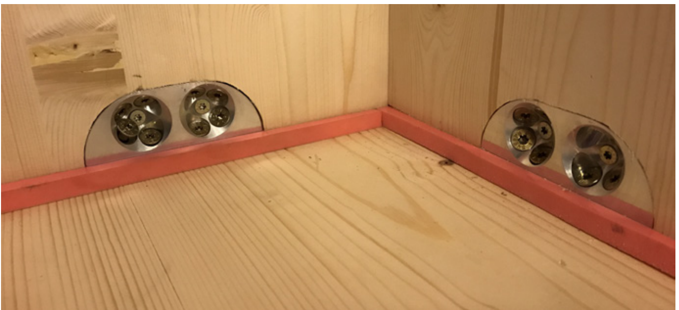
Befestigung mit SHERPA CLT-Connector
