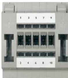
Prüfsteckleiste für Spannungswandler
