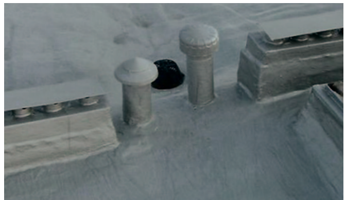
Dachdurchdringungen unterschiedlicher Art
