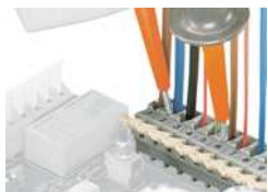
Prüfen mit Prüfspitzen
