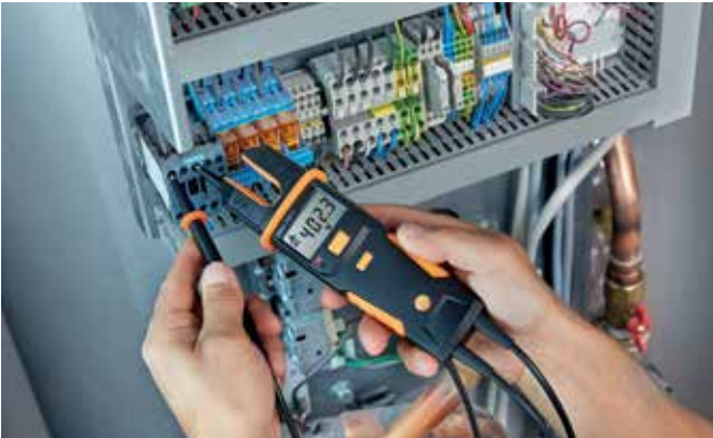
Spannungsprüfung an einer Wärmepumpe mit testo 755 .
