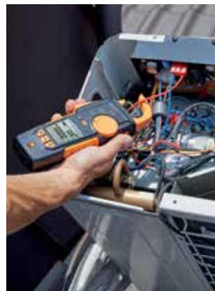
Einfädeln der Stromzange an einer Kälte-Außeneinheit.
