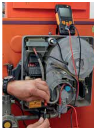
Aufbau der Ionisationsstrom-messung.
