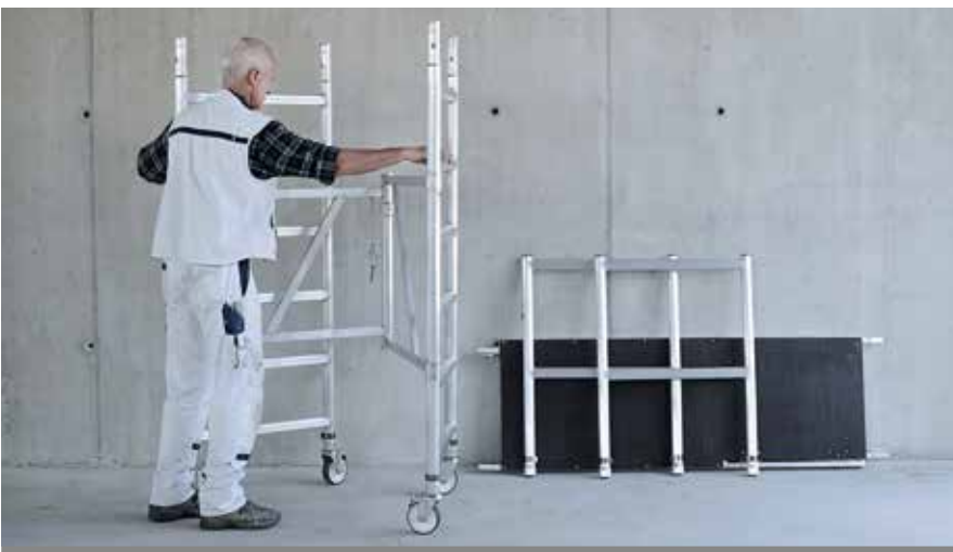
Schritt 2: Klapprahmeneinheit aufstellen
