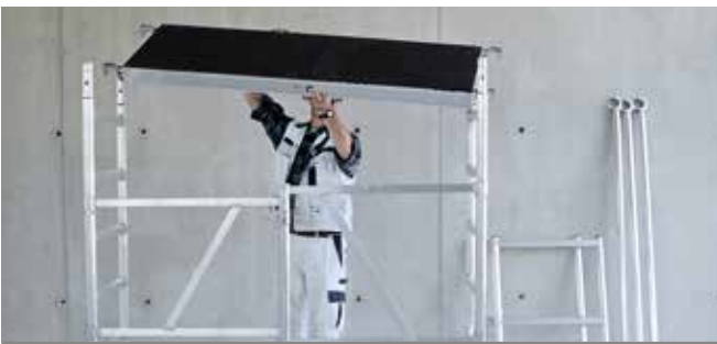
Schritt 4: Plattform einhängen
