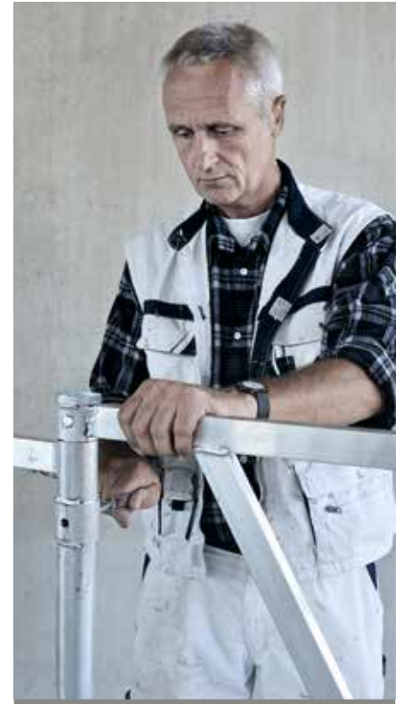
Schritt 3: Klapprahmen mit Splint fixieren
