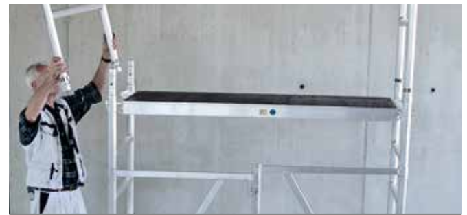
Schritt 5: Geländerrahmen aufstecken
