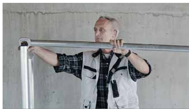
Schritt 7: Streben befestigen
