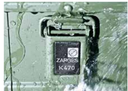
Schutzart IP 67 durch patentiertes ZARGES Verschluss-System
