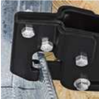
Das Stempelwerkzeug wird durch die Profilbleche gedrückt
