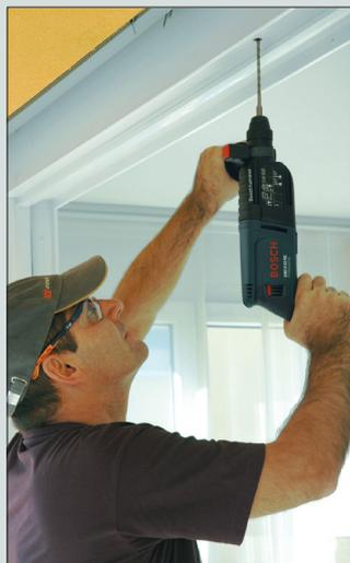
**1.** Bohren Sie durch die obere Weite ein Loch Ø 12 mm, anschliessend in die Betondecke ein Loch Ø 8 mm und Tiefe 60 mm.
