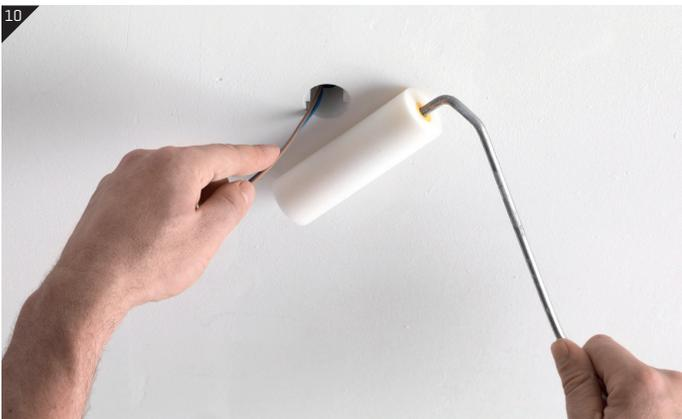
Nach dem Schleifen entfernen Sie die Schutzkappe und ziehen das Kabel nach vorne. Ungenauigkeiten sind händisch nachzubessern. After sanding, remove protective cover and pull cable to the front. Imprecisions have to be reworked by hand.
