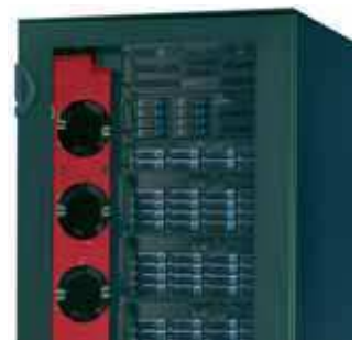
Luft/Wasser-Wärmetauscher
