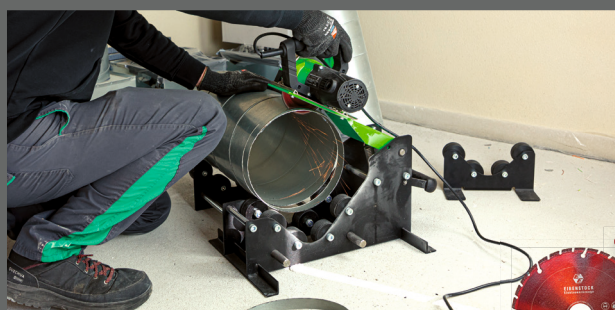
Zeitsparendes Trennen von Lüftungsrohren
