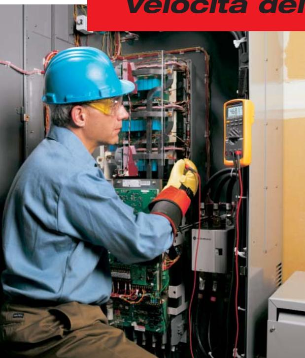
**Il multimetro digitale Fluke 87V risolve i problemi derivanti da apparecchiature dotate di motorini con regolatori di velocità. Queste apparecchiature, mediante la modulazione dell'ampiezza di impulso, regolano la velocità dei motorini a corrente alternata, generando un segnale particolarmente irregolare o "rumoroso".**
