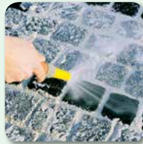
mit Wassersprühstrahl und feuchtem Besen abreinigen
