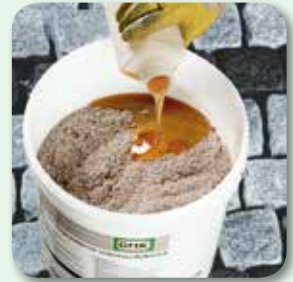
Bindemittelkomponente zugeben
