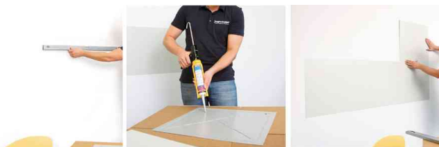
Wandfläche ausmessen - Platten mit Kleber versehen - die magnetowand® entsteht
