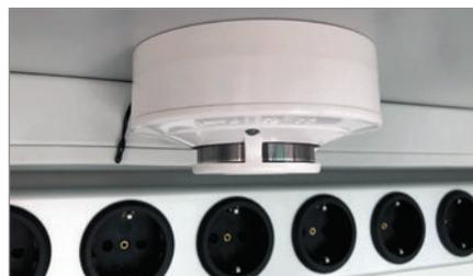
Rauchmelder zur Überwachung auftretender Rauchentwicklung im Schrank.
